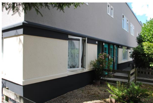
Buitenschilderwerk op beton.
