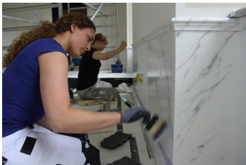
Het aanbrengen van een imitatie van witmarmer.
