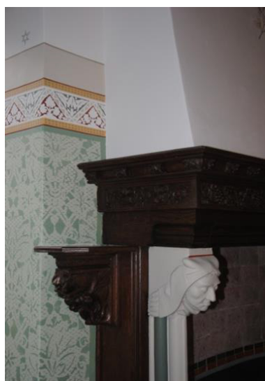
Binnenschilderwerk op steen afgewerkt met decoratief sjabloneerwerk.
