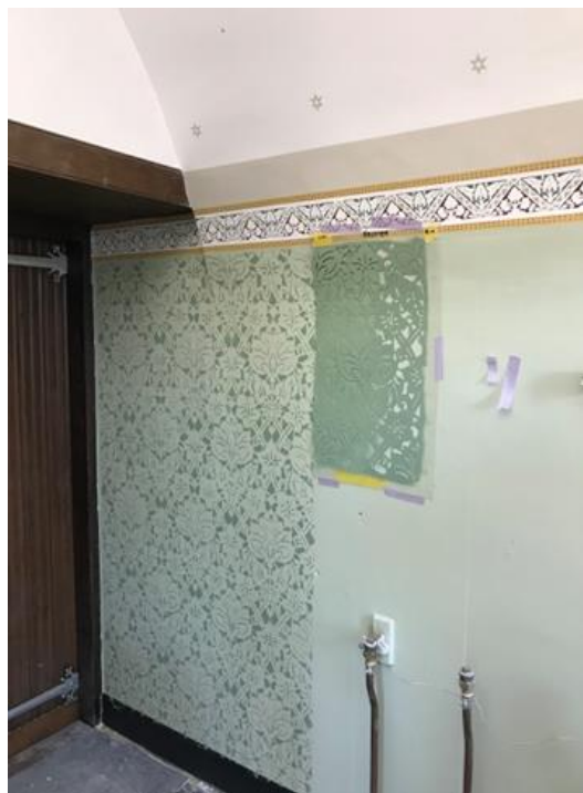
Het aanbrengen van sjabloneerwerk in kasteel 'De Haar' Haarzuilen.
