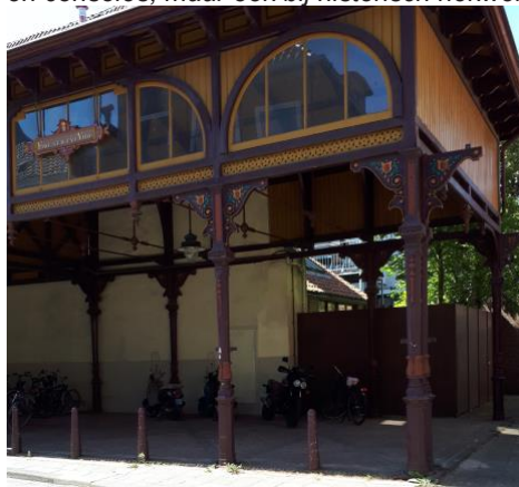
Gebouw aan de Botermarkt in Deventer uit 1886/1889 met geschilderde gietijzeren draagconstructie
