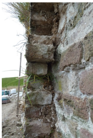
Afbeelding 3: Lateraalscheur
