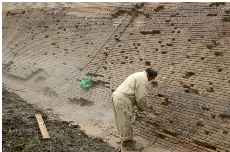
Afbeelding 1. Zeer plaatselijk uitnemen van individuele baksteen
