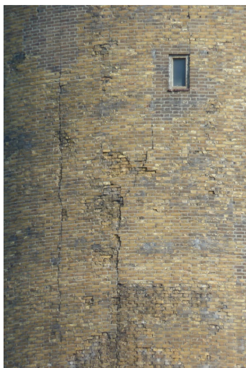
Afbeelding 5: Transversaalscheuren
