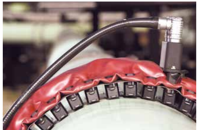
Guided Wave soveltuu erikokoisten ja -tyyppisten putkien korroosiokartoitukseen.
