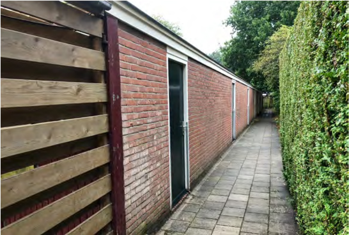
Niet verlicht achterpad met overhangend groen. Hier zijn nog maatregelen nodig.
