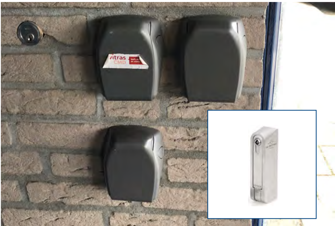
Als er een sleutelkluisje wordt toegepast moet deze minimaal de certificatie SKG 2-sterren hebben. Deze kluisjes voldoen niet aan de eisen. Het kluisje op de inzetfoto is gecertificeerd.
