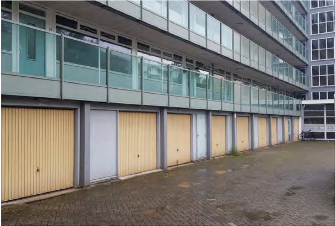
Garagedeuren in de buitenschil van een gebouw. Elke box is voorzien van verlichting.
