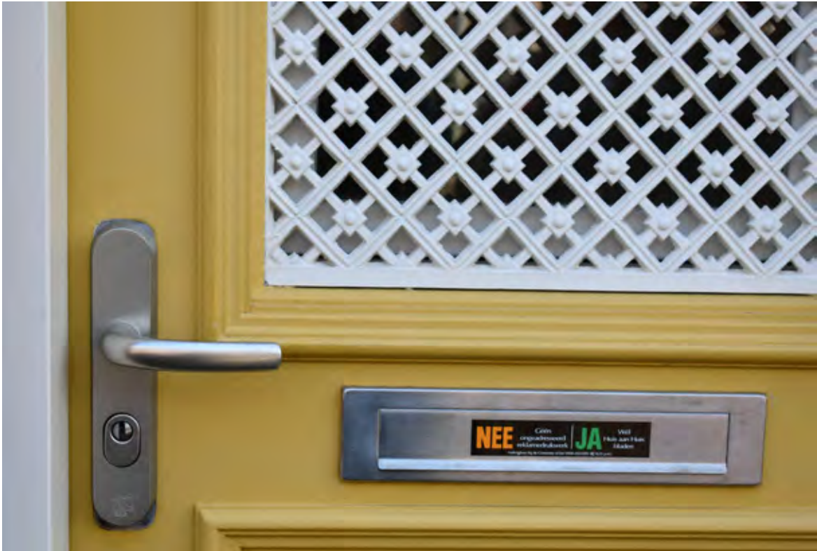
Veiligheidsbeslag met cilindertrekbeveiliging toegepast.
