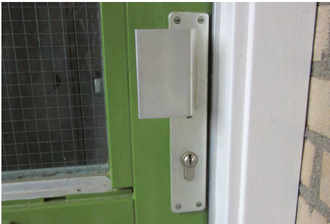
Verouderd beslag biedt geen bescherming tegen cilindertrekken en het afbreken van de cilinder.
