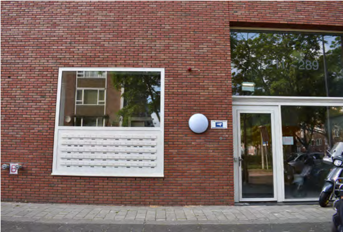
Postkasten zijn bij voorkeur buiten aangebracht. De buitenzijde is bij de entree voorzien van 1 verlichtingsarmatuur met schemerschakeling
