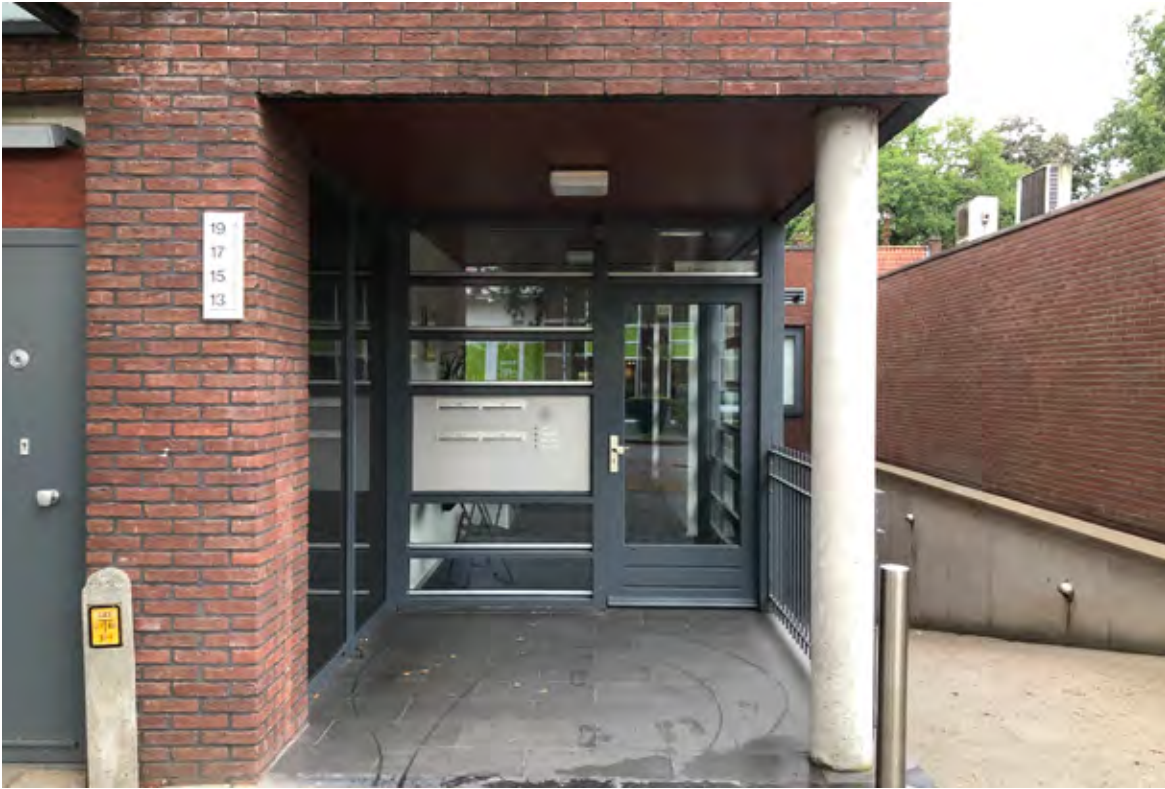
Toegangsdeuren tot gemeenschappelijke ruimten in het woongebouw zijn zelfsluitend en beveiligd tegen 'flipperen'.
