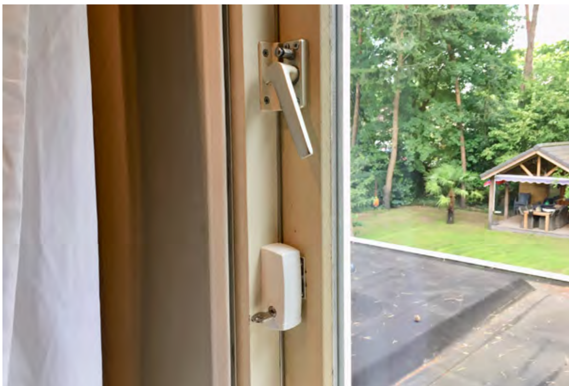
Dit raam voldoet aan 3 minuten inbraakwerendheid door de bijplaatsing van een oplegslot (SKG 2 sterren).
