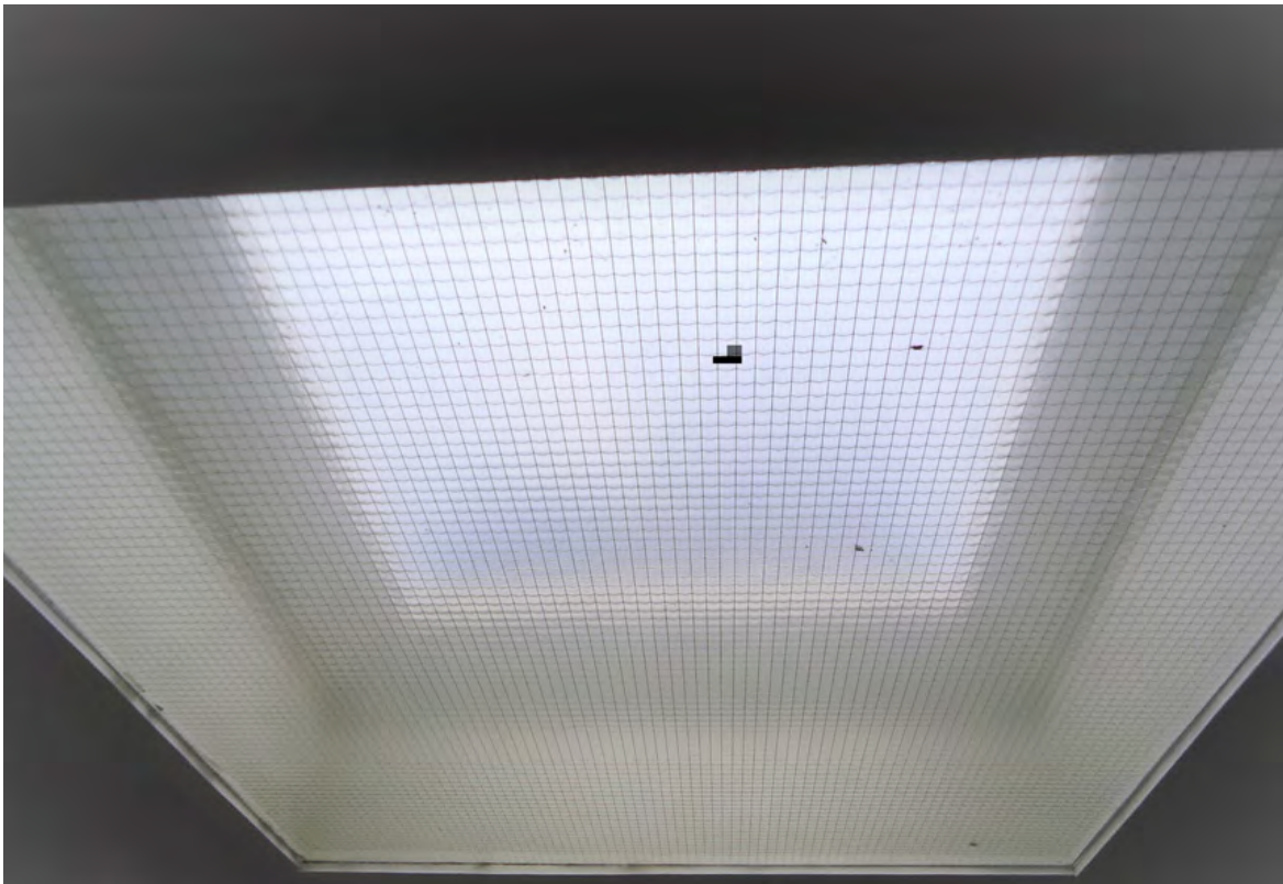
Een lichtkoepel van een woning kan aan de binnenzijde afgeschermd worden met glas als de buitenkant niet inbraakwerend is.
