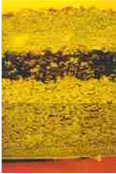
Afbeelding van dwarsdoorsnede SBS bitumen dakbaan met een wapening die is gedrenkt met een afwijkend type bitumen.
